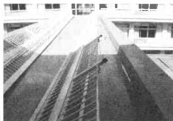
B棟間通路
